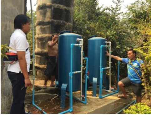
ชาวหมู่บ้านห้วยยาโน ซึ่งเป็นหมู่บ้านขนาดเล็ก ในชุมชนห้วยก้างปลาช่วยกันติดตั้งถังกรองน้ำ © IUCN/Angela Jöhl Cadena
