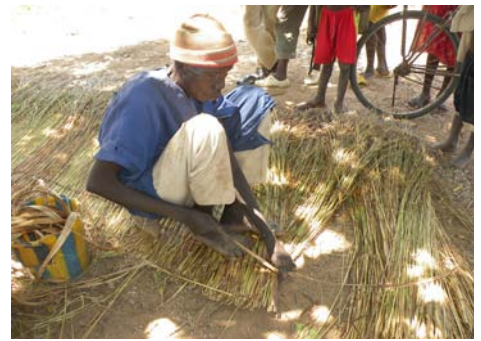
Artisan en pleine fabrication de toit de chaume - Lomié, Cameroun
