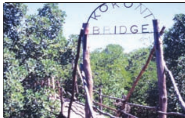
Passerelle de l'île de Wasini
