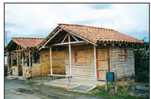
Figure 13: Kiosque en bambou
