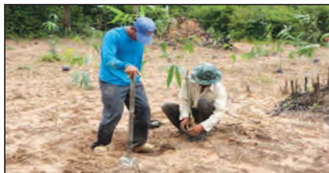
Figure 61 : Remplissage de la fosse de terre supérieure
