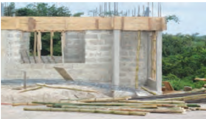
Figure 37 : Bambou comme support pour dalle à l'Ouest-Cameroun, Droite :
