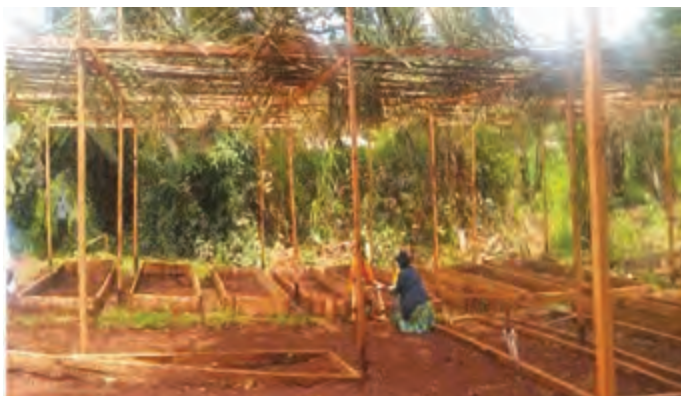
Figure 46 : Installations de base de la pépinière de bambou
