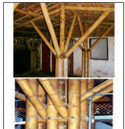
Figure 12: Constructions de toits : constituées de plusieurs chaumes avec des connecteurs intégrés
