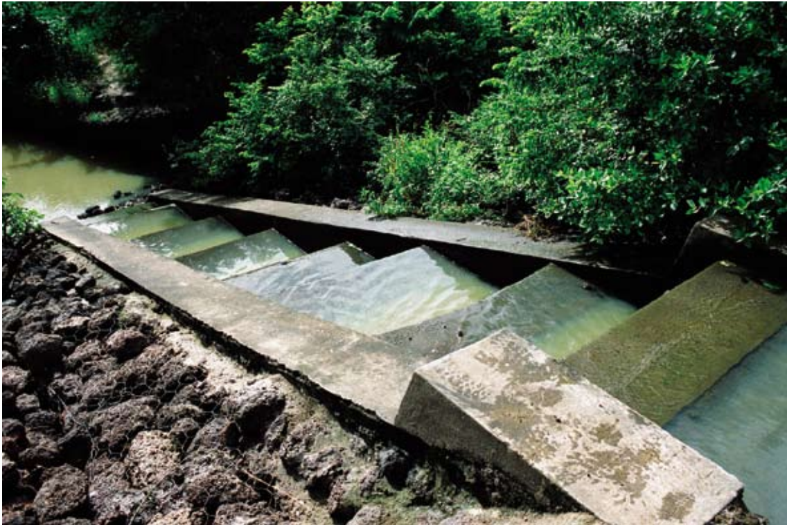
Kênh bậc thang giúp cá di cư qua đập lấy nước tưới ở Burkina Faso. Kênh bậc thang cho cá là một cải tiến quan trọng về cơ sở hạ tầng đi kèm với việc xả dòng chảy môi trường.
