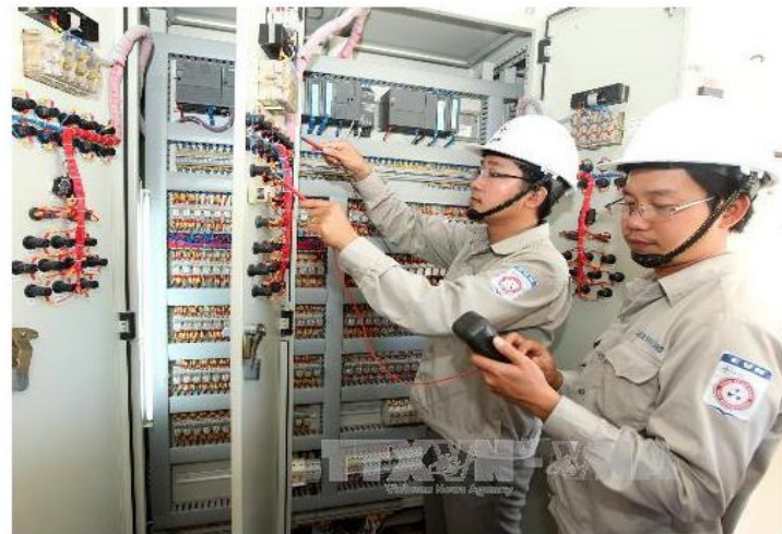
Công nhân Công ty CP Thủy điện A Vương bảo dưỡng thiết bị điều khiển nâng hạ cửa van cung tại đập A Vương trên sông Vu Gia - Thu Bồn. Ảnh: Ngọc Hà/TTXVN.
