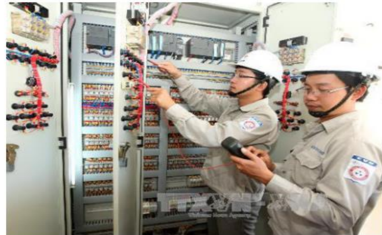
Công nhân Công ty CP Thủy điện A Vương bảo dưỡng thiết bị điều khiển nâng hạ cửa van cung tại đập A Vương trên sông Vu Gia - Thu Bồn. Ảnh: Ngọc Hà/TTXVN.
